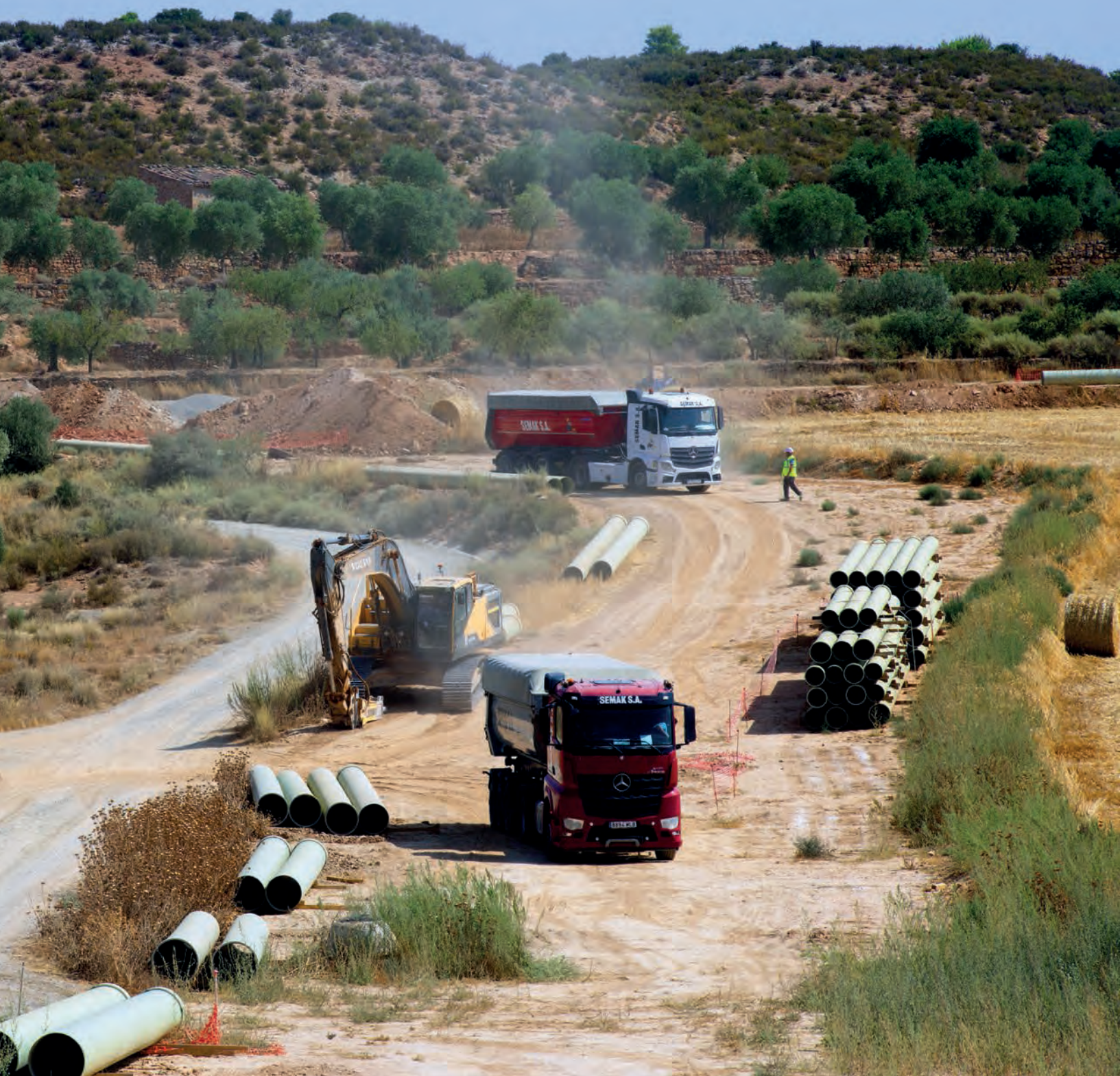
◆ Obres de construcció d'un nou tram del canal Segarra-Garrigues, als sectors 10, 11 i 14.
