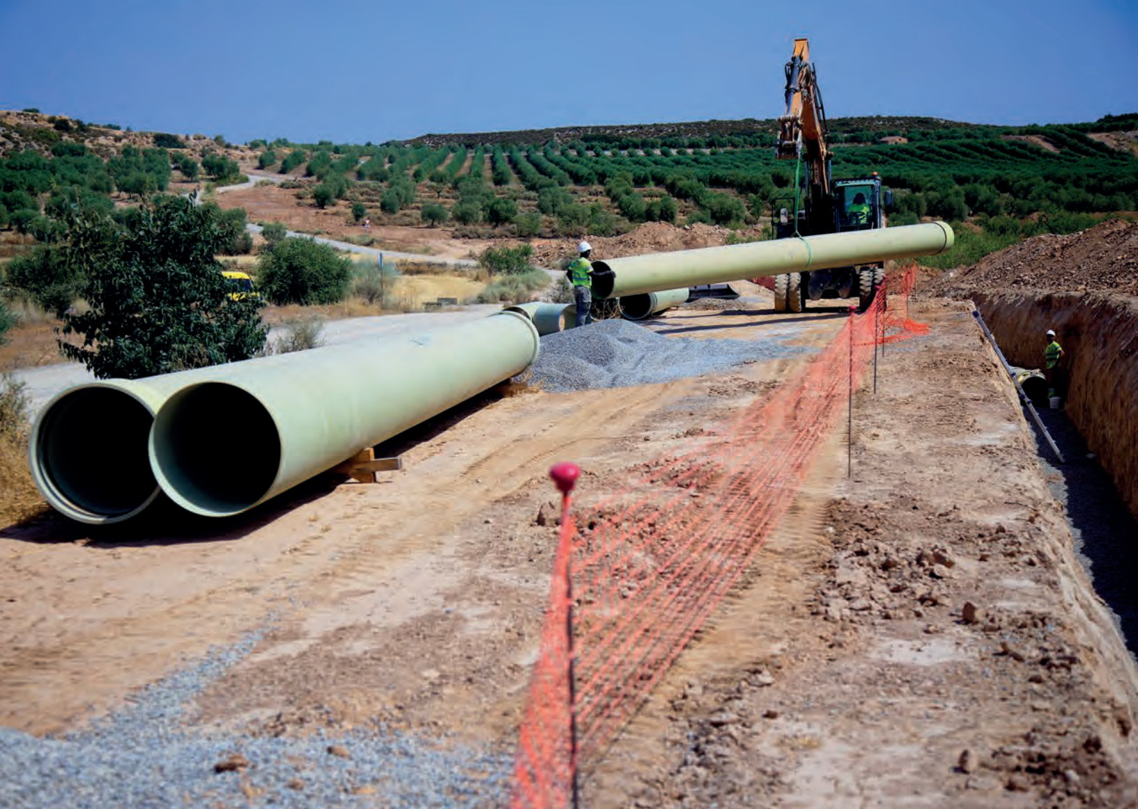
◆ Obres de construcció d'un nou tram del canal Segarra-Garrigues, als sectors 10, 11 i 14.
